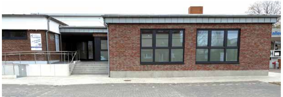
Unser Foto zeigt den neuangebauten Teil der Praxis Pohlmann in Wagenfeld am Hallen-Freibad. Ein neuer Eingangsbereich mit einer langgestreckten Auffahrt für Gehbehinderte (links) sorgt für einen ungehinderten Zugang zum großzügig angelegten Eingangsbereich. Auch der Zugang ist von den Parkplätzen aus bequem zu erreichen. Foto: Reinhard Kawemeyer
